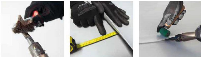
Figura 4. Procedimiento manual de soldadura de lona PVC. Fuente: Manual de instaladores Renolit S.A.
