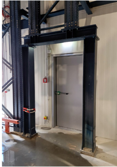
Figura 7.2. Vista real del pòrtic
