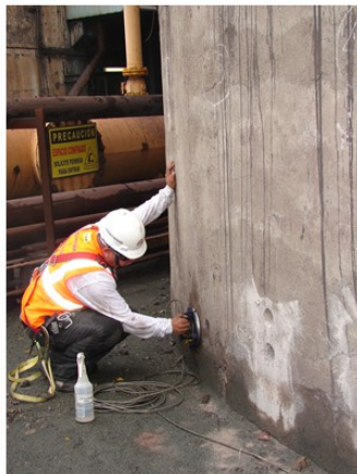
Figura 8. Medición de Velocidad de Corrosión
