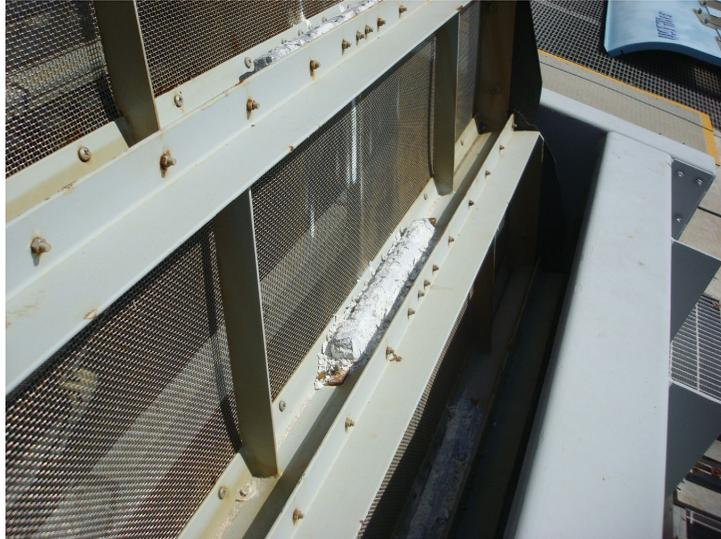
*Figura 9. Protección catódica por medio de ánodos de sacrificio que ha sido instalada para proteger de la corrosión a los filtros de agua de mara utilizada en los vaporizadores de una planta de regasificación de gas natural licuado*
