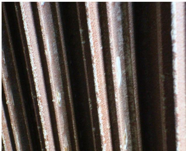
Figura 8. Corrosión en y depósitos en tubos de aluminio de un vaporizador de gas natural licuado expuesto a agua de mar por la cara exterior
