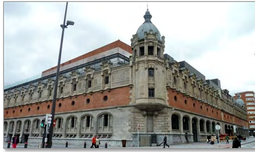
Figura 4.2: Alhóndiga de Bilbao.
