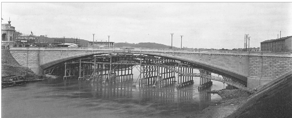
Figura 1.3: Puente de Risorgimento sobre el río Tiber, Roma. Diseñado por Giovanni Antonio Porcheddu y construido por la empresa Hennebique en 1911 con hormigón armado.
