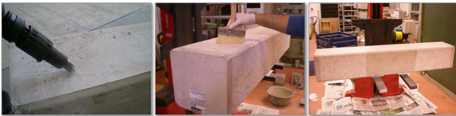
Figura 5.12: Preparación de las superficies de la estructura existente.
