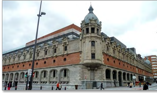
Figura 4.2: Alhóndiga de Bilbao.
