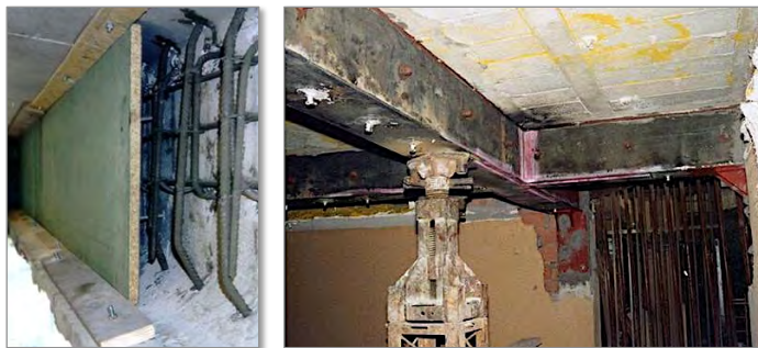
Figura 4.4: Recrecido de hormigón (izquierda) y pegado de chapas de acero (derecha).
