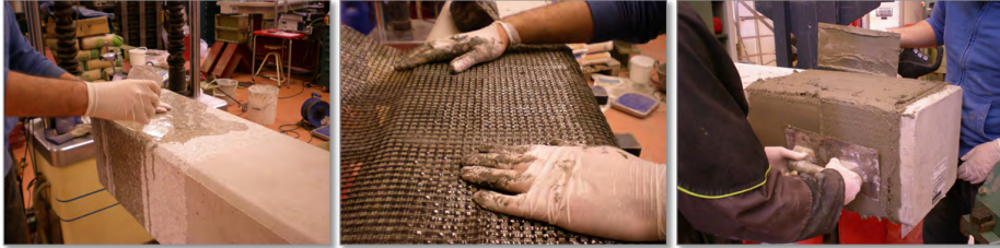
Figura 5.13: Aplicación del refuerzo.
