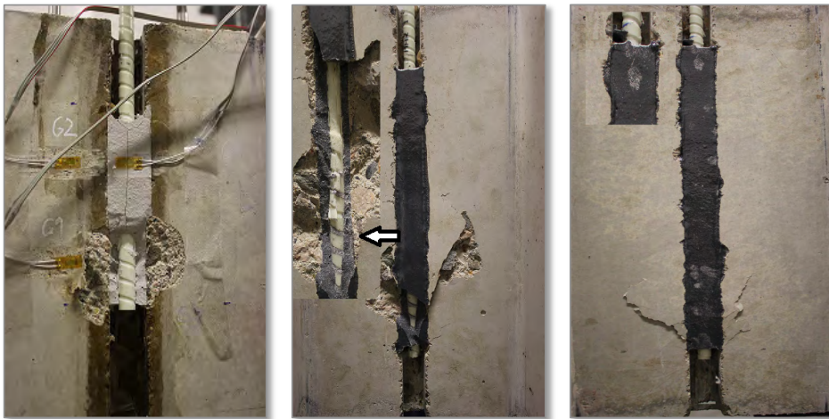
Figura 7.7: Modo de fallo especímenes con barras de GFRP .
