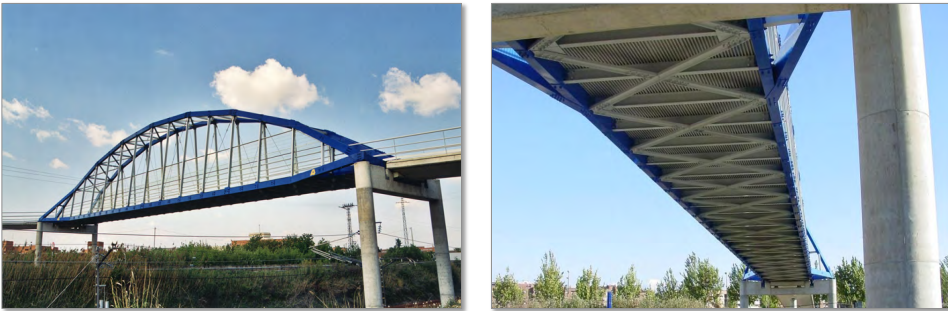
Figura 9.3: Vista general de la pasarela construida con PFRP en Lleida, España (por cortesía de PEDELTA) [32].
