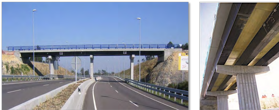
Figura 9.4: Estructura híbrida de un puente de carretera en Asturias, España (por cortesía de Acciona Infraestructuras) [4].
